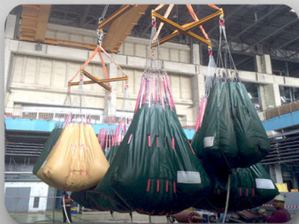
Épreuve en charge pont roulant 90 T
