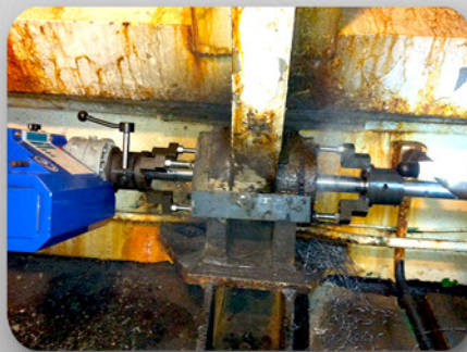
Alésage de charnières sur site
