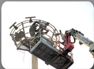
Installation de pylône d'éclairage
