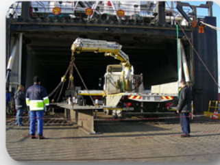
Travaux sur structures
