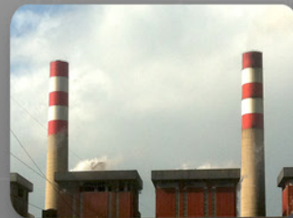
Installation de système de balisage de cheminée
