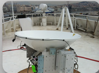
Installation d'antenne radio
