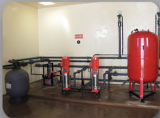
Installation de stations de pompage
