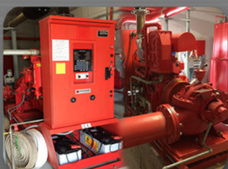
Réparation et maintenance des systèmes anti-incendie
