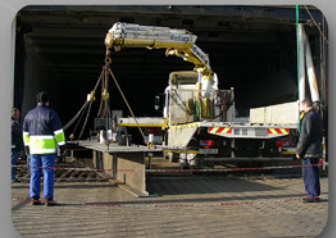
Fabrication et installation de structures métalliques
